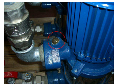
Figure 6: Montage du transducteur dans le trou d'évent \frac{1}{4} "
